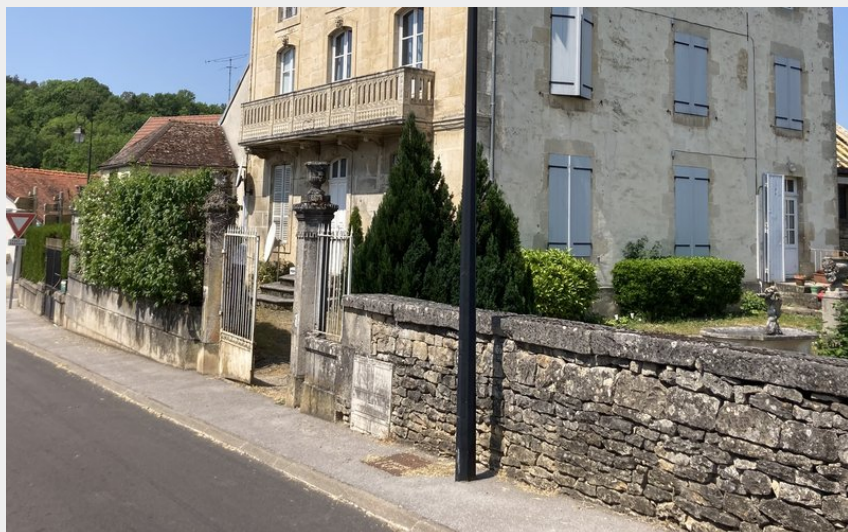
Attribution : façade coté rue vu du haut (BAUDRY)
